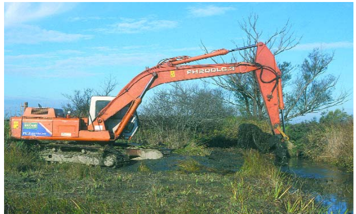
Curage d'une roubine entièrement colmatée (Marais de Sollac-Fos).
